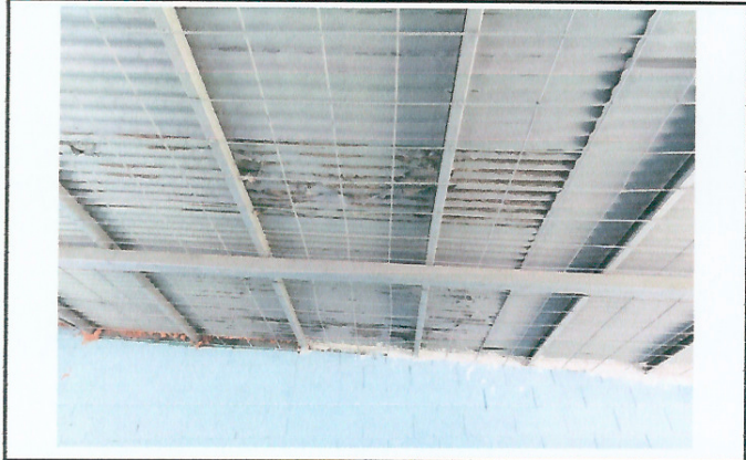
Foto 1: Mejoramiento y sustición de cubierto de lamina.
