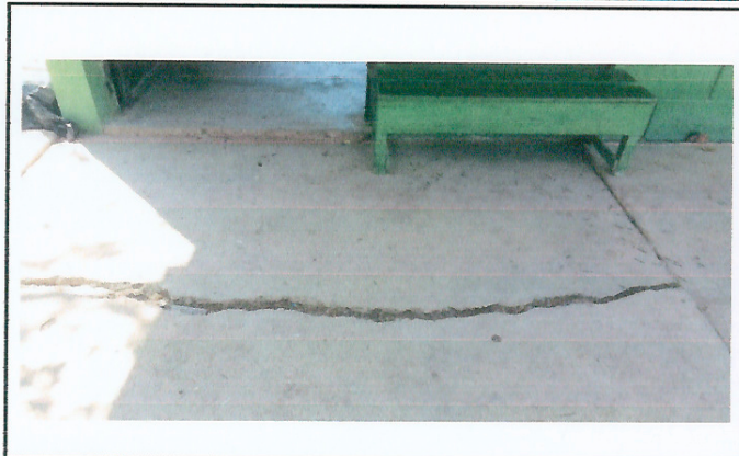
Foto 2: Mejoramiento y sustitución de piso.
