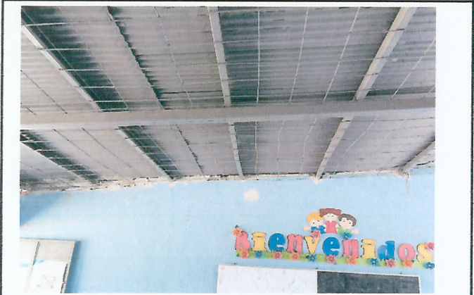
Foto 3: Reparación de repello y cernido de paredes.
